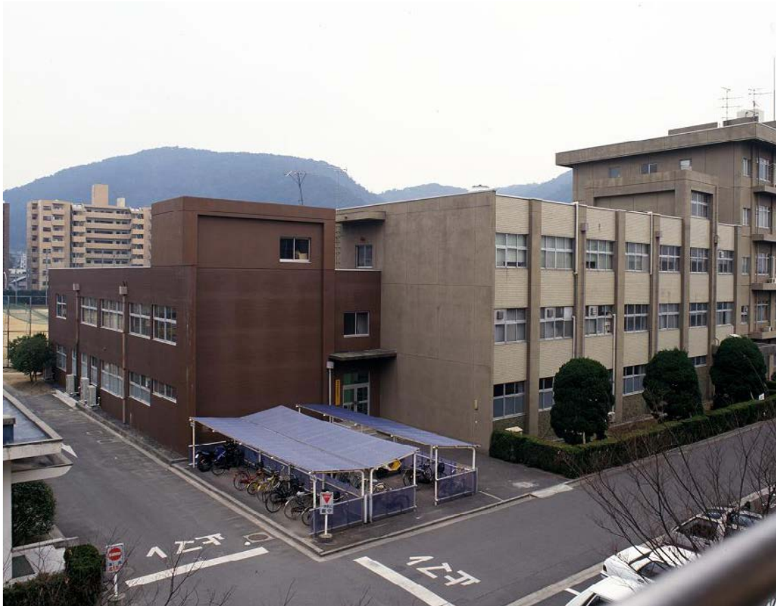
情報処理センター建物全景(南2号館の3階より平成4年頃撮影)
